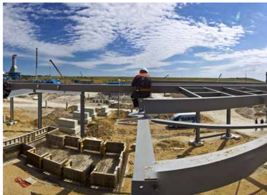
КС «Писаревка». Монтаж металлоконструкций
