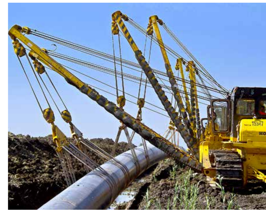
На строительстве газопровода в рамках реализации проекта «Южный коридор» (2014 г.)
