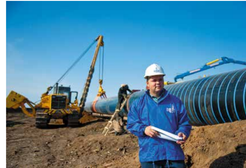
Андрей Андреевич на строительстве газопровода «Южный поток»
