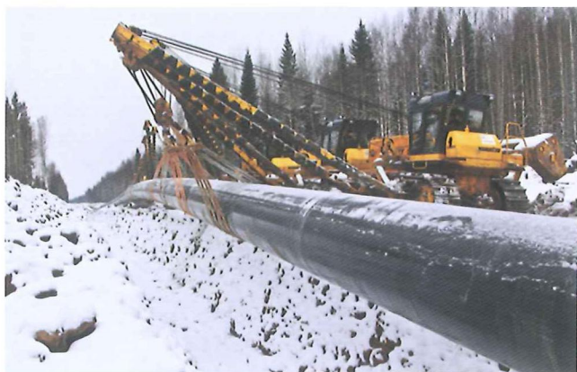
Строительство СМГ Ухта – Торжок
