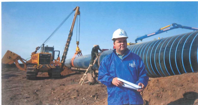
Андрей Андреевич на строительстве газопровода «Южный поток»
